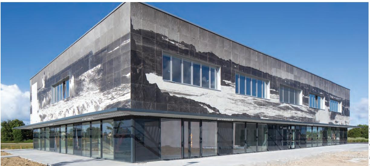
▲ Première mondiale : le parement béton réalisé à partir du liant i.design EFFIX ARCA de cette façade d'un immeuble au Château-d'Olonne (85) est imprimé. La photographie panoramique qui a été "tatouée" mesure de 110 mètres de long sur 6 mètres de large !
